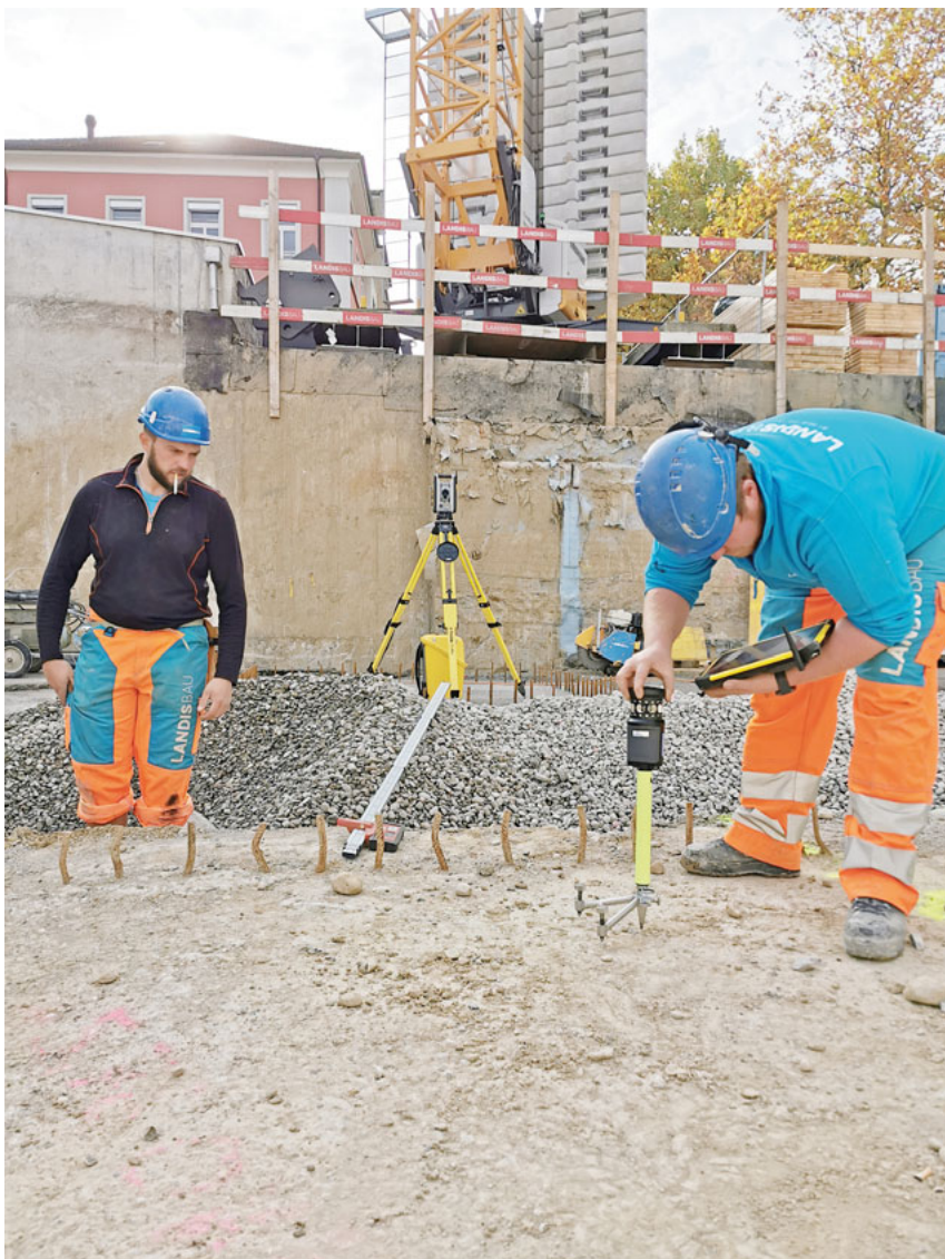
Robotische Totalstationen – längst Standard auf den Baustellen der Landis Bau AG und beim konsequent modellbasierten Bauen unverzichtbar.
