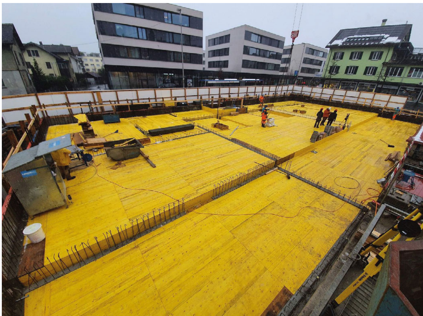
BIM2Field: Modellbasiert entsteht das Wohn- und Geschäftshaus an der Marktgasse in Baar.
